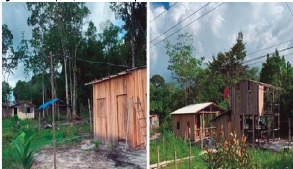
Figura 1 – Mosqueiro/Belém. Moradias precárias na Comunidade Vitória do Portal. 2023
