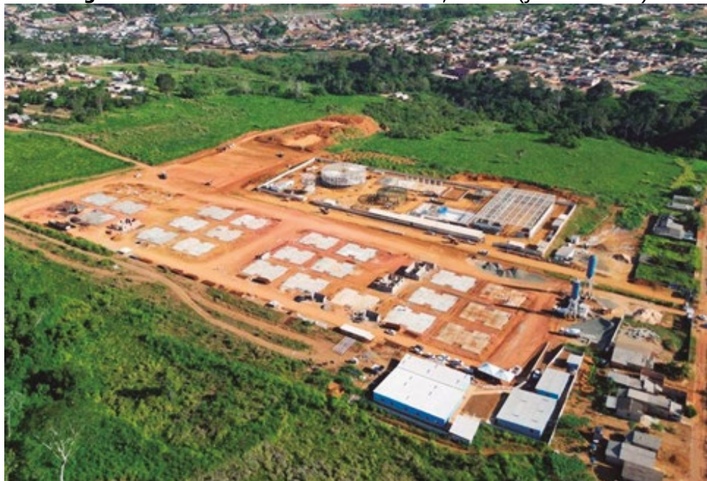
Figura 3 – Obras dos residenciais Altamira I, II e III (julho de 2025)
