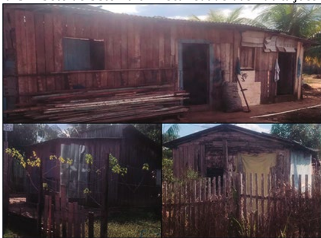
Figura 3 – Sete de Setembro. Precariedade das habitações. 2022
