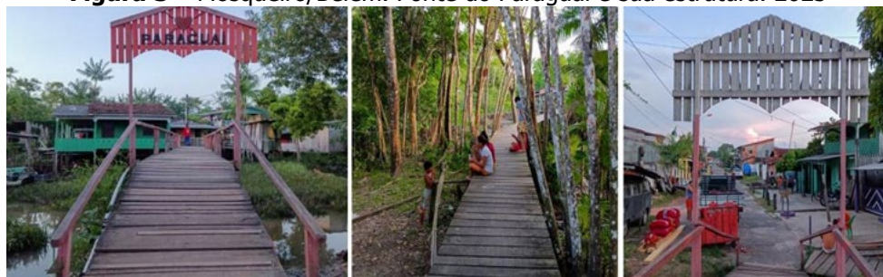
Figura 3 – Mosqueiro/Belém. Ponte do Paraguai e sua estrutura. 2023
